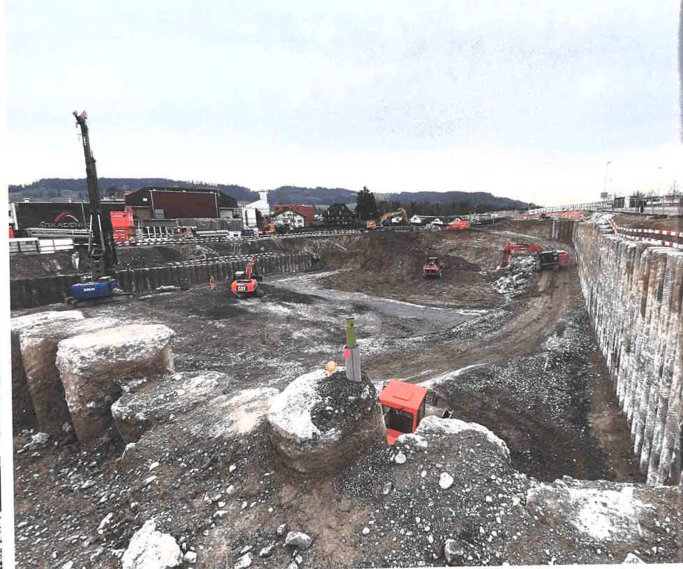
Baugrube mit Bohrpfahlwand.
