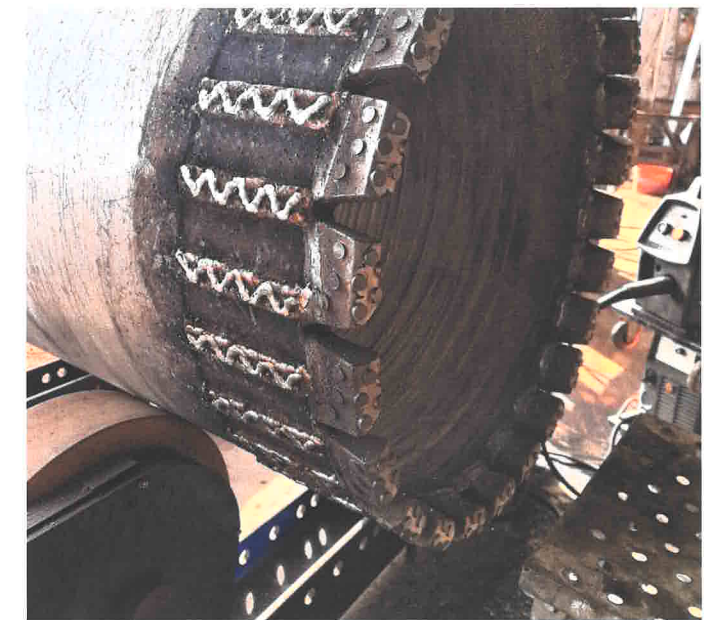
Repariertes Fussrohr mit Anschweisstollen.
