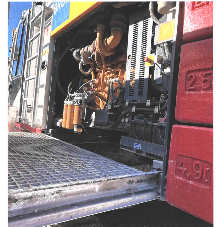
Servicearbeiten am Motor des Drehbohrgeräts BG28H.
